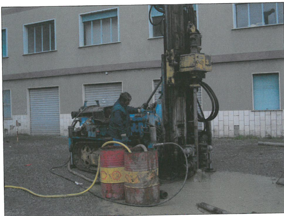
Foto n.1: Attrezzatura per esecuzione sondaggio geognostico S1
